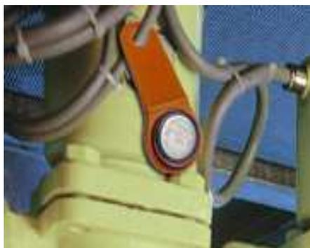
Несомненным преимуществом устройств ТЕРМОХРОН является возможность непрерывного температурного контроля во время реальной эксплуатации инженерных систем без какого-либо изменения режима их работы и без необходимости прокладки каких-либо сигнальных и питающих кабелей.
