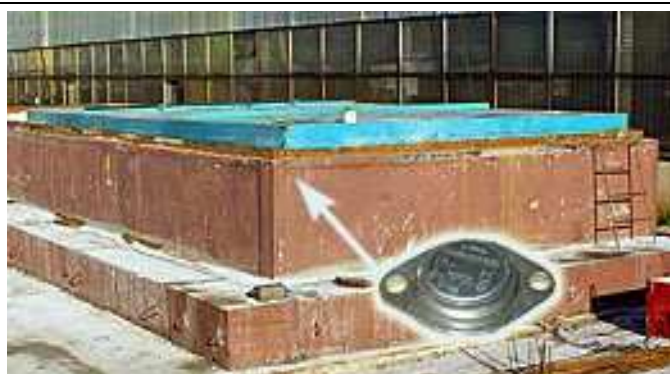
Реализация методов контроля и прогнозирования температурно- прочностных параметров бетона, в том числе в зимних условиях
