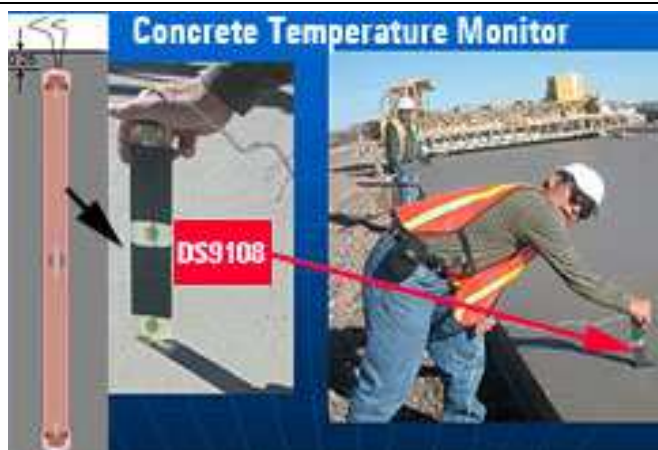
Температурный контроль качества дорожных покрытий
