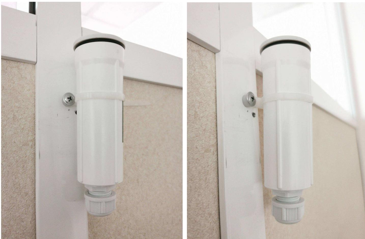
**Способ 3.** Использование для крепления тега ремешков для труб и кабеля с установочной площадкой подходящего размера. Например, изделие PRNT 32-63 от компании ЕВРОПАРТНЕР, или аналогичный хомутный держатель со стяжкой CFF2 32-63 от компании iEK.
